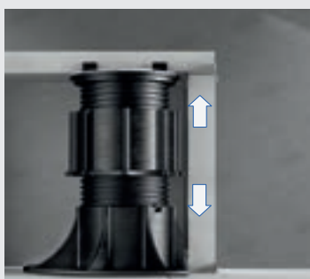
Installazione tamponamento verticale
