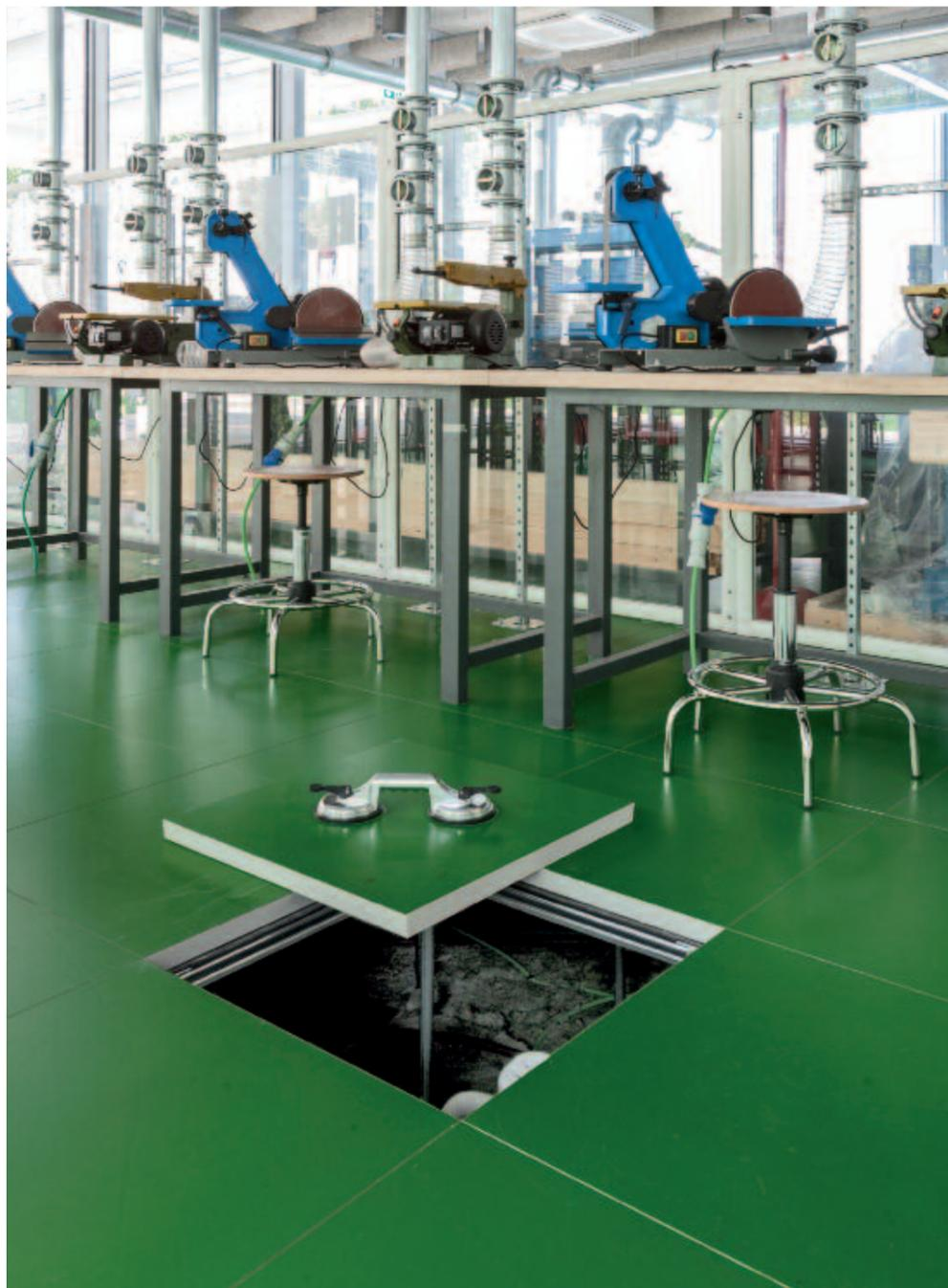
Laboratori Politecnico - Pannello in solfato di calcio, rivestimento in linoleum, formato 60x60.
