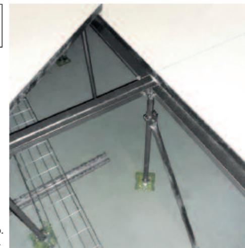
Particolare di struttura tipo KGX4 con tirante antisismico.
