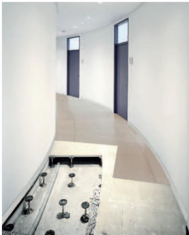
Moduli composti da lastre di gres porcellanato autoposante con retro in polietilene e bordo in materiale plastico. Ottima soluzione per il rivestimento di pavimenti sopraelevati grezzi o per il restyling di pavimenti tradizionali.
