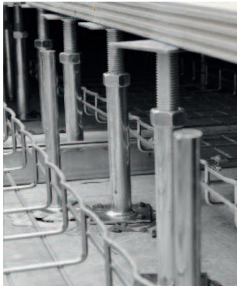
Struttura portante rinforzata costituita da colonne con filetti, basi e teste maggiorate.
