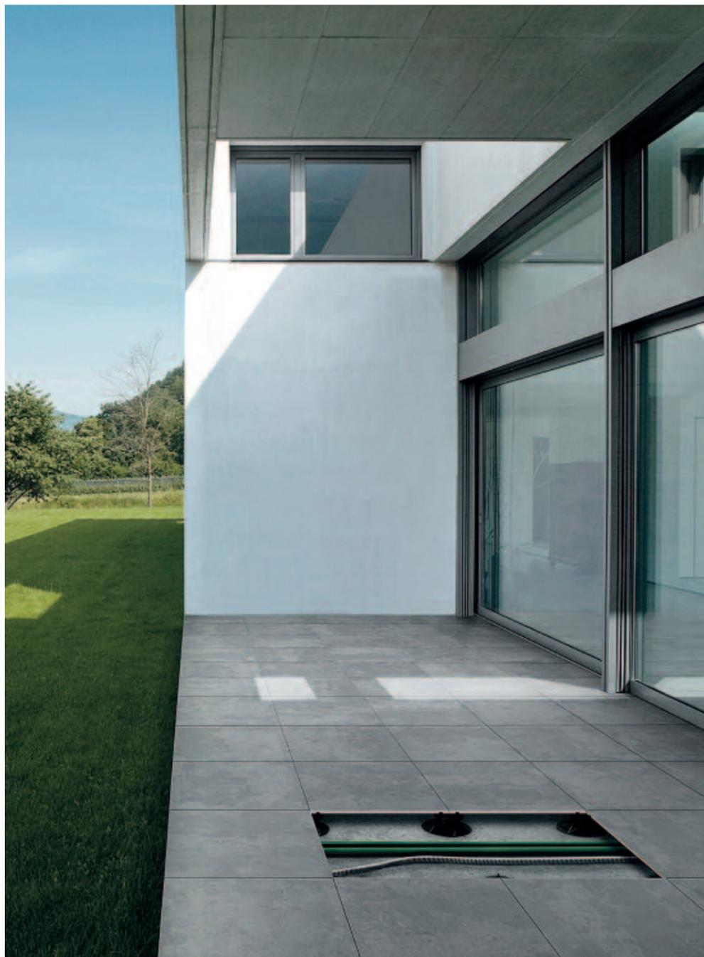
I pannelli sono posati in opera, in appoggio su supporti in materiale plastico resistente agli sbalzi di temperatura, alle soluzioni acide e basiche ed agli agenti atmosferici. Il livellamento finale della pavimentazione è possibile grazie alla ghiera che permette la regolazione micrometrica dell'altezza nella parte alta del supporto.
