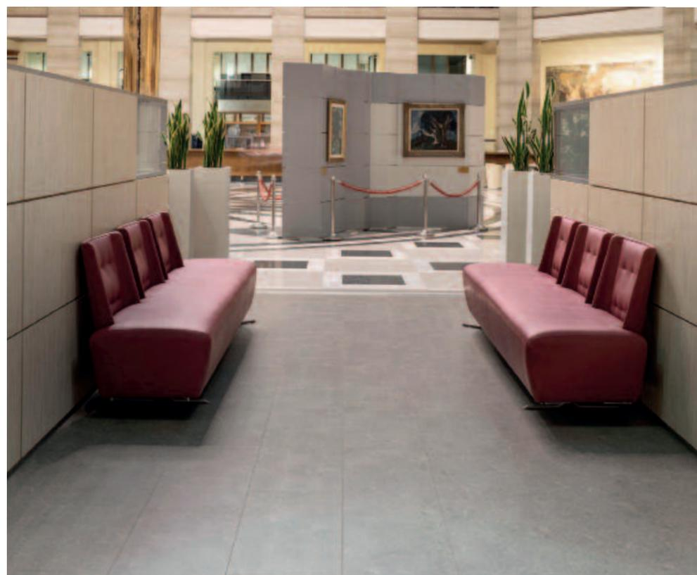
Moduli composti da una lastra in gres porcellanato su cui è applicato un rivestimento inferiore in sughero o polietilene espanso di 2 mm di spessore con funzione di antipattinamento. La finitura laterale è realizzata con bordo autoestinguente in materiale plastico con spessore da 0,6 mm, che riduce la frizione perimetrale. Colori standard: grigio, beige, nero. A richiesta altre colorazioni.
